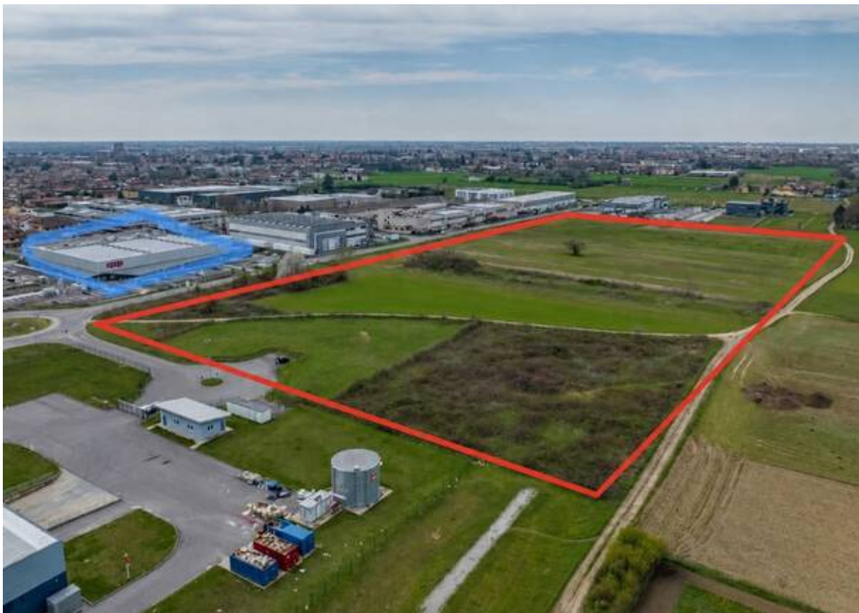
Aree destinate a ospitare il nuovo data center di Cesate
