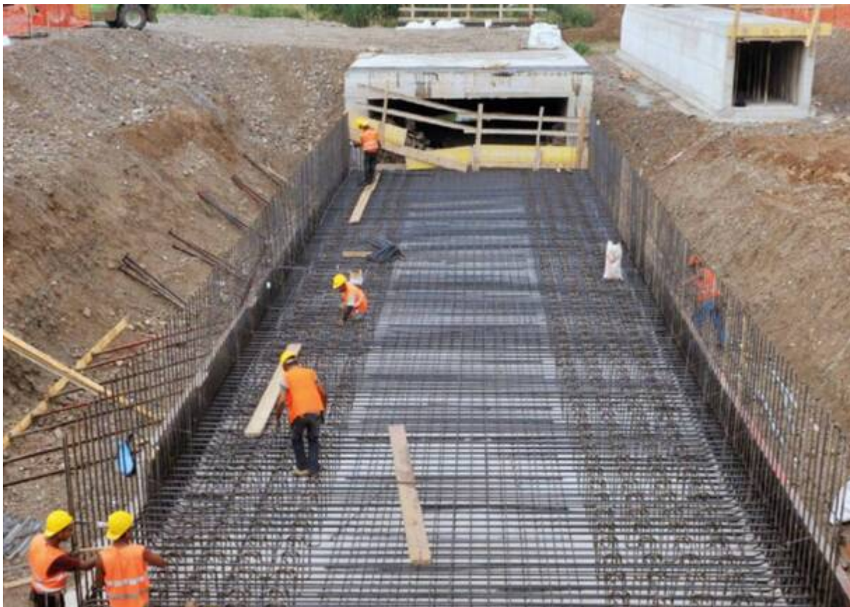
Cantiere di Pedemontana, foto bergamonews.it
