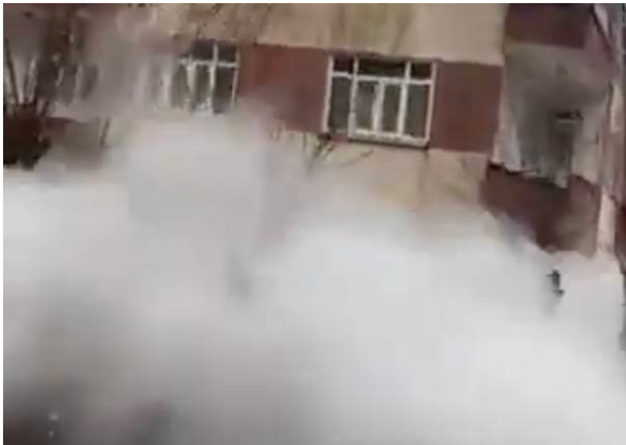
Crollo di un palazzo a Sanliurfa
