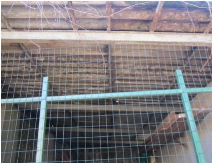
**Bonifica da lastre di cemento-amianto al Parco del Seminario.** Secondo quanto previsto dal piano di smaltimento dell'amianto del Comune di Saronno, sono state effettuate **la rimozione e lo smaltimento della copertura in lastre di cemento-amianto** del deposito attrezzature della Protezione Civile presso il Parco del Seminario.
