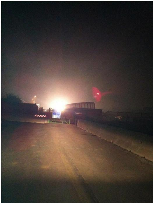
Il ponte sull'autostrada è **stato spostato**. La traslazione è avvenuta lentamente nei giorni scorsi ed è stata ultimata nelle ultime ore. I lavori accessori **non sono ancora terminati** ma il grosso dell'operazione è avvenuto senza intoppi: il ponte di via IV novembre è **stato spostato di qualche decina di metri**, pochi centimetri al giorno **tramite l'uso di "martinetti" e speciali binari**.
