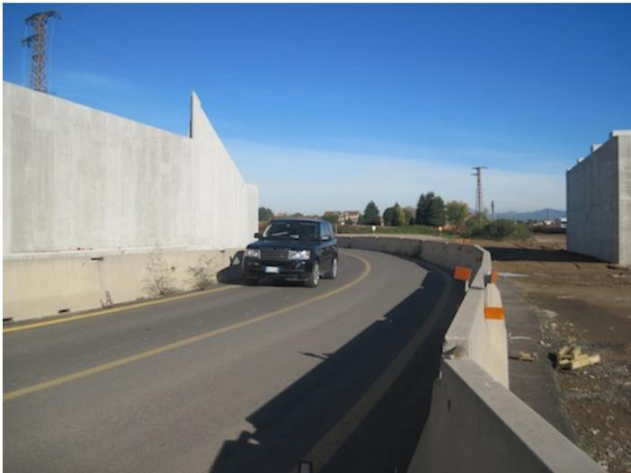
Non ci sono più solo chilometri di recinzione arancione. Sono sorti anche diversi “muri”, opere che sosterranno le rampe di accelerazione e decelerazione dello svincolo autostradale Uboldo-Origgio. I diversi cantieri dell’ampliamento della terza corsia dell’autostrada A9, di cui il grande svincolo a semi-quadrifoglio fa parte, procedono celermente.
